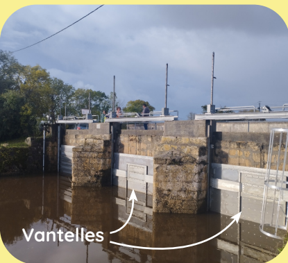
Ouvrage du Passage après travaux.
