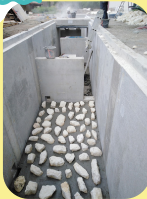
Ouvrage en cours de construction
