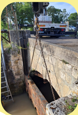
Retrait des anciennes vannes
